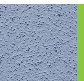
Hochwertige Außenputze und -farben schützen Wände vor eindringendem Wasser und verhindern dadurch, dass Kohlendioxid und Salze die Materialstrukturen des Betons angreifen.
